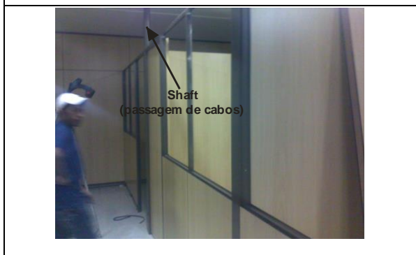
Figura 03: Modelo de Shaft para passagem de cabos piso teto em que as divisórias terão 2,30 cm de altura
