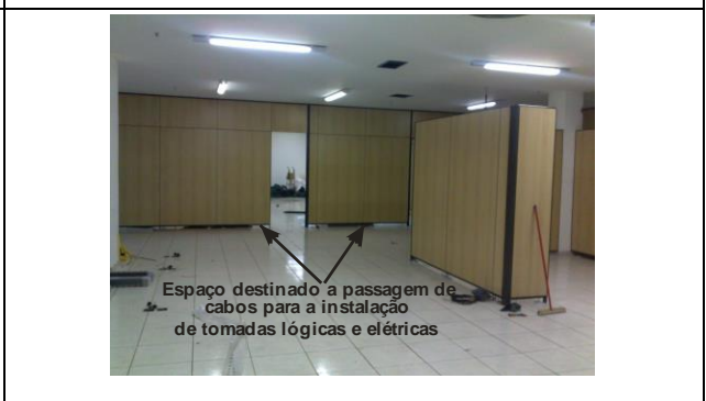
Figura 04: Espaço para passagem de cabos
