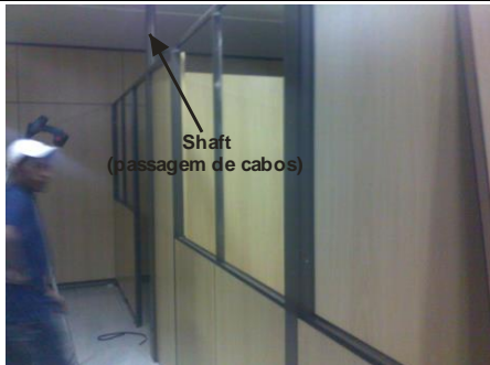
Figura 03: Modelo de Shaft para passagem de cabos piso teto em que as divisórias terão 2,30 cm de altura
